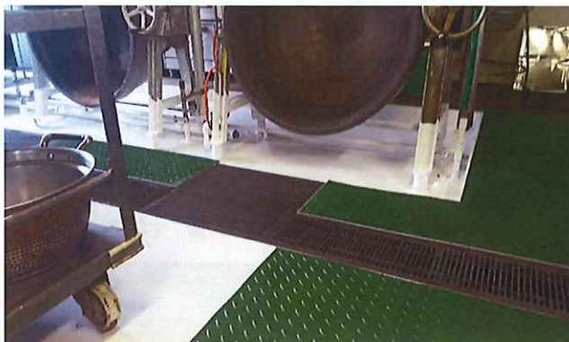
2017年5月 約40年経過の厨房防水:工期2日
