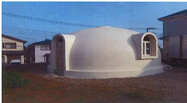
立面や天井にもシームレス施工
