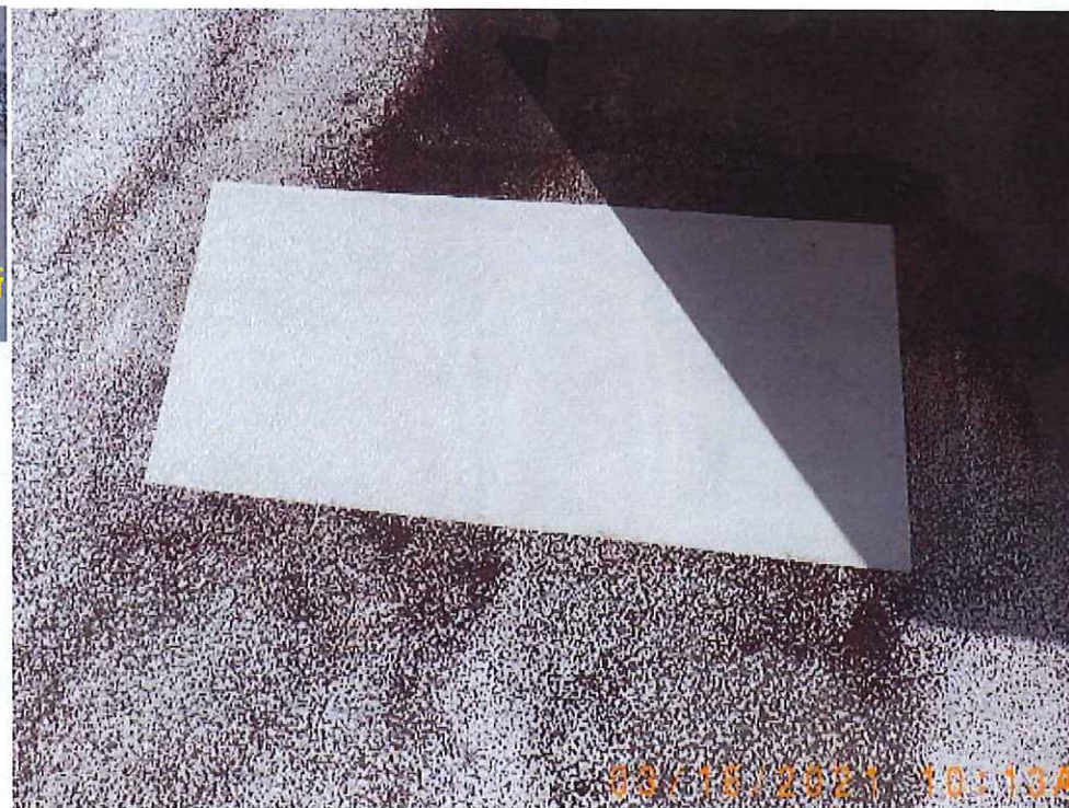
2021年3月 某イベントホールの10年点検写真 旧タイプのトップコートでもほとんど劣化無し
