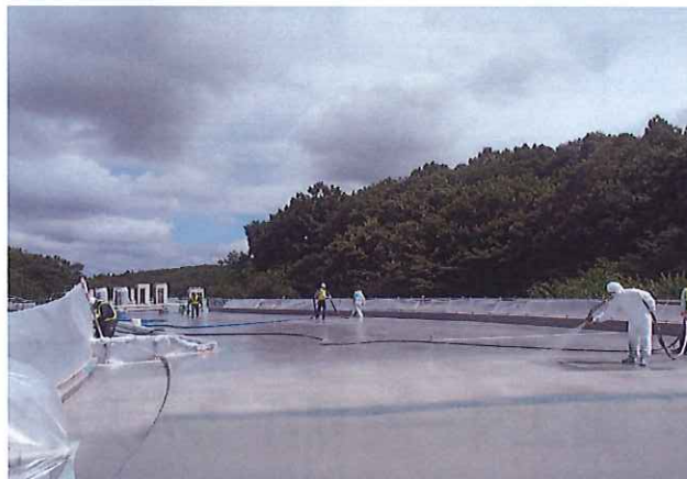
2017年5月 T大学屋上防水
