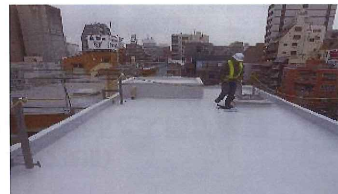
2015年3月 リムシート屋上全面防水施工
