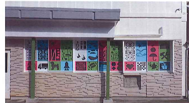
50年経過工場の外断熱防水（弊社）
