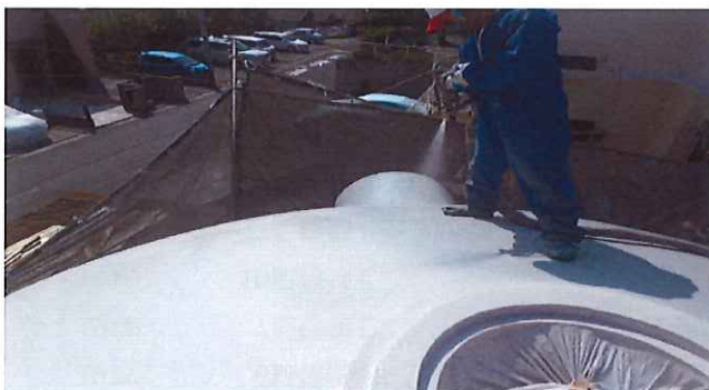
曲面へのリムクイック施工
