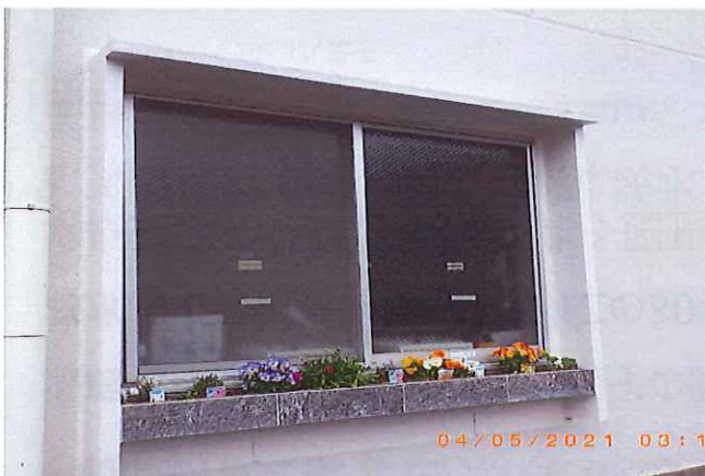
断熱材をウレアコーティングの庇 軽量化：庇が熱くならず輻射熱が減
