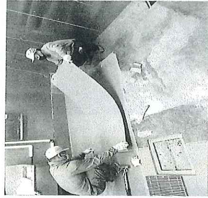
写真3 厨房床の防水改修実例
