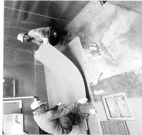
写真3 厨房床の防水改修実例
