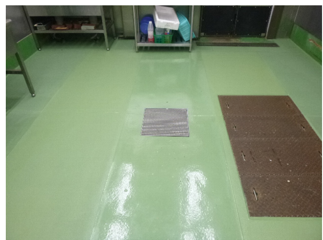
◀ ジョイント部のシーリングにもポリウレア樹脂を使用
