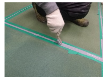
◀ ジョイント部のシーリングにもポリウレア樹脂を使用
