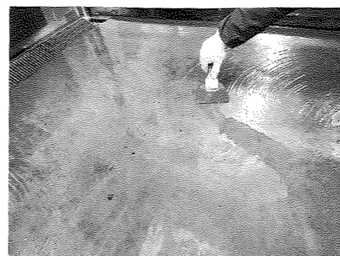
写真2 湿潤面用プライマー使用状況
