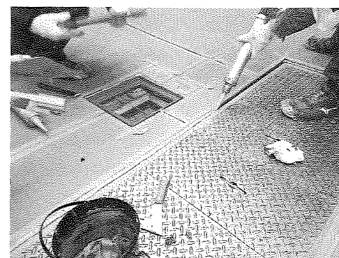
写真5 ポリウレタ樹脂系接着剤兼シーリング材の打設
