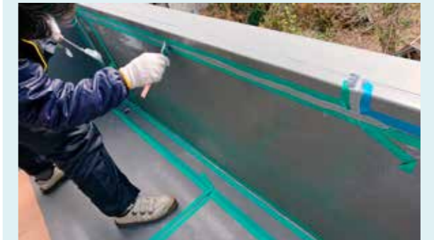
バルコニー リムシート施工写真
