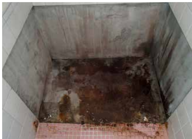
浴室を撤去後、水洗いする場合があります。
