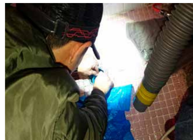
ライニング作業風景
