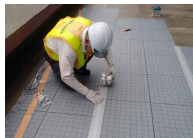
通気緩衝工法 - CAマットSB使用例
