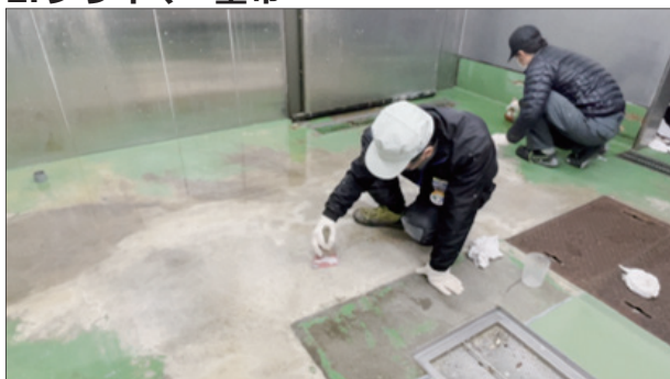
2. プライマー塗布
