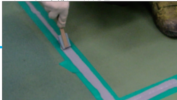
5. ジョイント部シール処理
